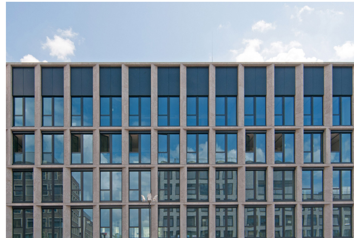
Hauptzentrale der GAG
